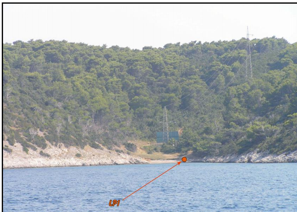
Slika 2.2-5. Pogled na KS Travnica (o. Hvar) s prikazom lokacije ulaska postojećeg kabela u more (izvor: HHI Split, 2007.)
